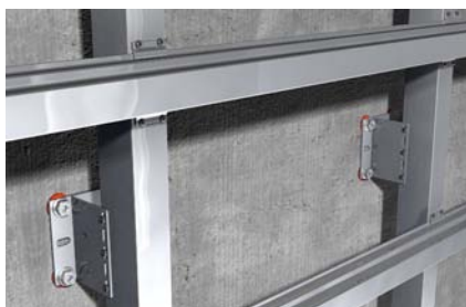
Nosné konstrukce fasád
