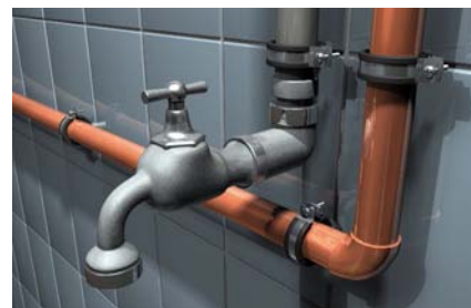
Instalace sanitárního vybavení
