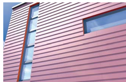
Nosné konstrukce fasád
