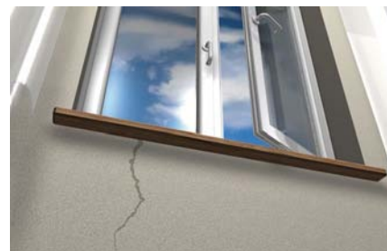
Vyplňování prasklin ve zdivu
