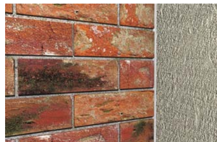
Dilatační spáry mezi budovami
