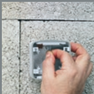
1/ Otvor urobíte zatlačením pomocou zakončovacieho nástroja
