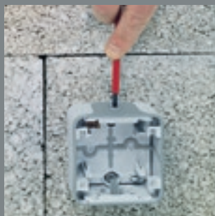
1/ Prepichnete membránu pomocou skrutkovača
