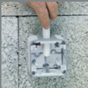
2/ Vložte trubku cez vytvorený otvor
