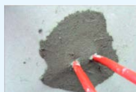
Elastickou maltou vyplníme vstup přes základový věnec budovy.
