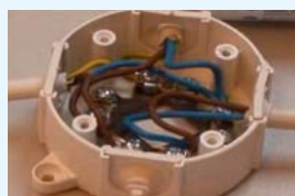
Zapojíme kabely do elektroinstalační krabice.
