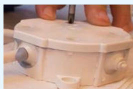
Víčko krabice po dotažení vytlačí přebytek materiálu.
