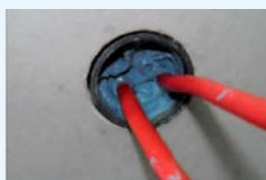
Necháme prostor pro elastickou maltu cca 5 cm.
