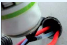
Vytvoříme zátku pomocí PUR pěny, necháme prostor cca 15 cm.
