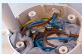
Prostředně aplikujeme Anticor Seal 511 od spodů,
