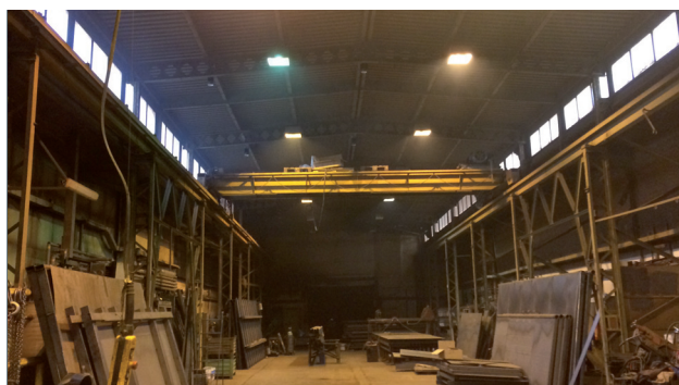
před instalací HIGH-BAY
